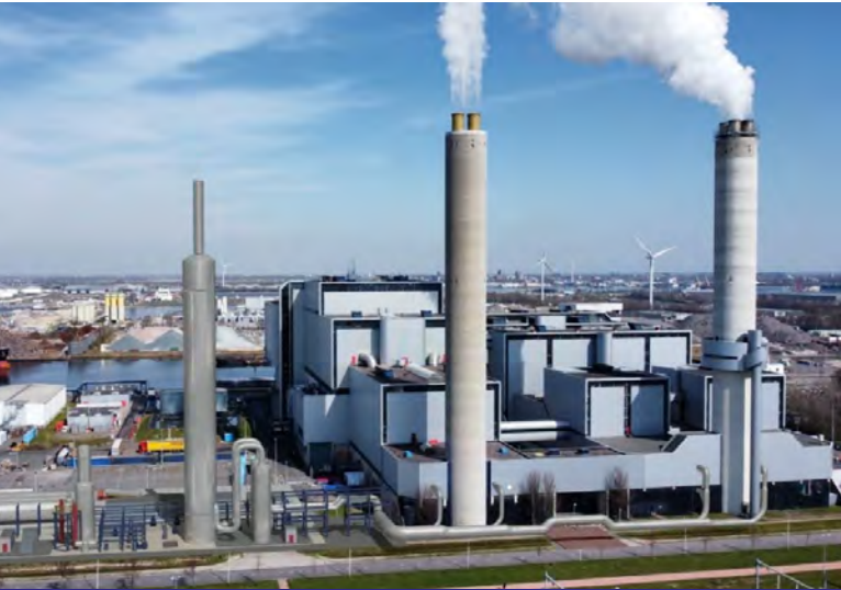
Een artist impression van AEB, met links op de voorgrond de CO 2 afvang installatie, inclusief nieuwe schoorsteen.
